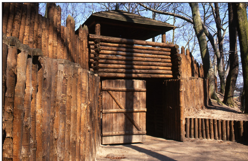
Zrekonstruowana brama wjazdowa na średniowieczne grodzisko w Sopotcie
