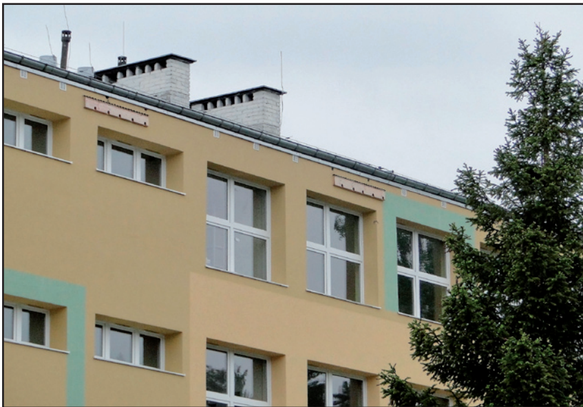
Panele budek lęgowych na fasadzie Szkoły Podstawowej nr 9 w Sopocie
