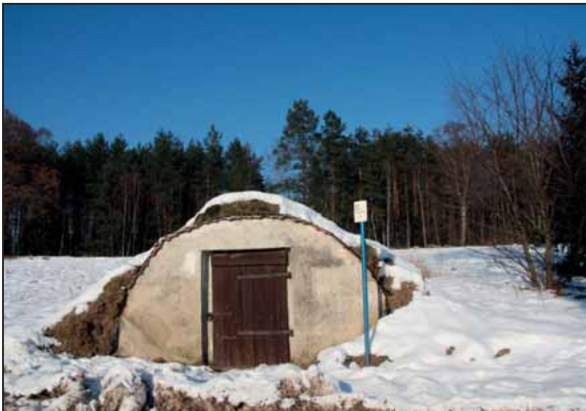
Wolnostojąca piwnica typu „ziemiańska”
