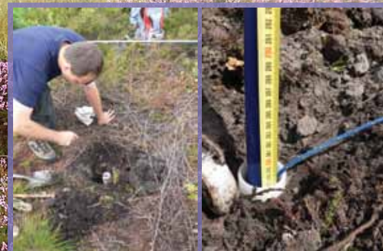
Zdj. Montaż studzienek kontrolnych.
