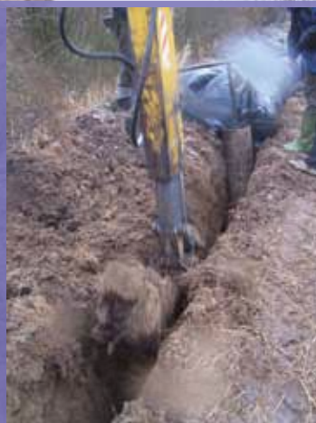
Rys. Zabieg uszczelniania krawędzi kopuły torfowiska.
