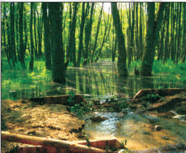
Zastawka piętrząca wodę na małym strumyku - dopływie Słupi. Zatrzymywanie wody w takich miejscach chroni przed wezbraniami niżej położone tereny.
